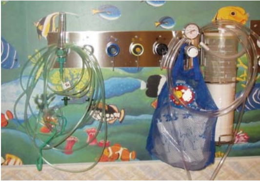
写真1 MRI室内配管
